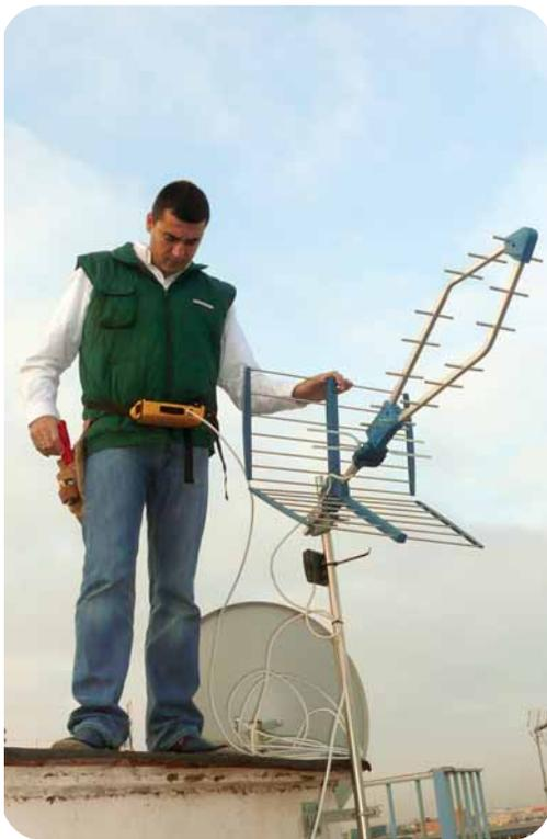
El **TVHUNTER** y el **SATHUNTER+** son instrumentos diseñados para la instalación de sistemas de recepción terrestre (DVB-T) y satélite (DVB-S/S2) respectivamente. Son completamente automáticos y muy fáciles de usar. Basta con orientar la antena y el instrumento mostrará la identificación del emisor o satélite seleccionados cuando sean detectados. El instrumento efectúa una lectura de la información transmitida por el proveedor del servicio mostrando en todo momento toda la información.
